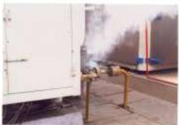
GAS LEAKAGE FROM PIPET LINE FLANGE OF BIHERO COMPRESSOR
